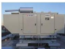
受変電設備（一括受電）非常用発電設備
