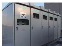
受変電設備（一括受電）非常用発電設備
