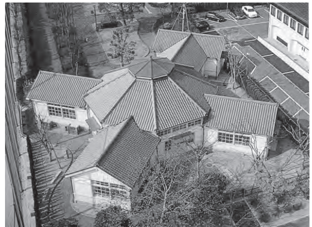
国指定重要文化財旧旭東幼稚園園舎
