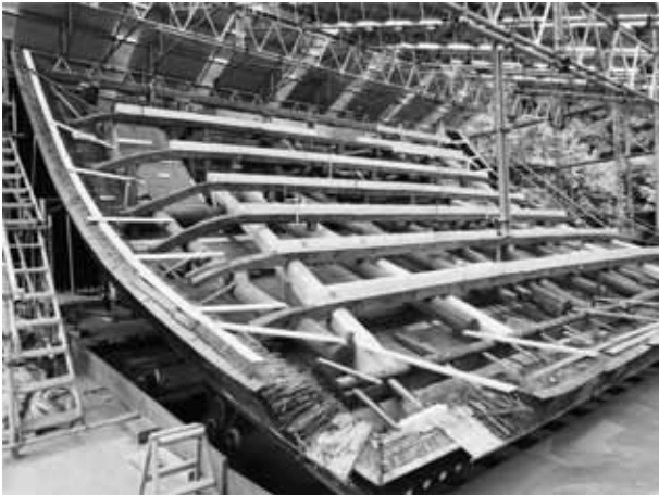
県指定重要文化財吉備津彦神社本殿修理
