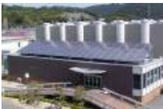
【三野浄水場の太陽光発電システム】
