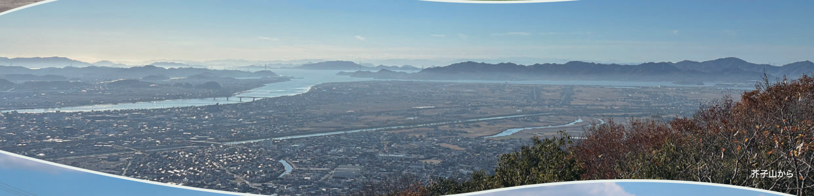
児島湾開墾第一区第一号干拓堤防
