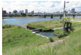
旭川(倉安川排水樋門)
