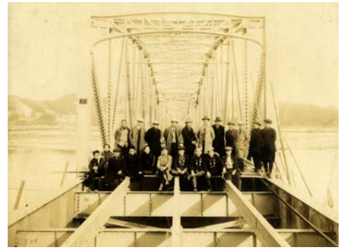
霞橋の建設風景（倉敷市）1928年（昭和3）頃 個人所蔵
