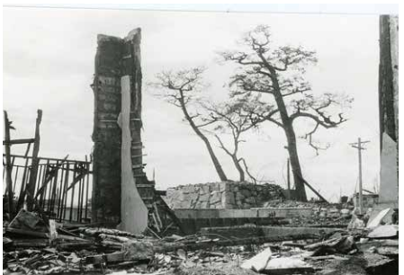
岡山城外下馬門跡 北区内山下 現岡山県立図書館付近
