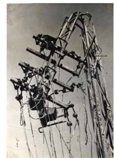
高熱で曲がった鉄塔
