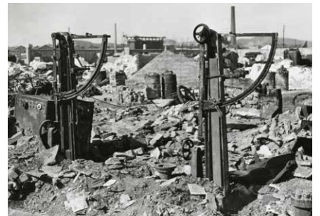
「現山陽新聞社付近」(北区下石井付近)
