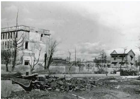
左の建物は旧岡山県図書館 北区蕃山町
