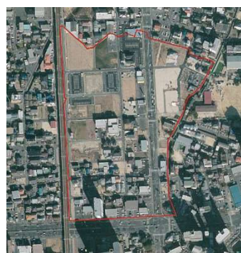
整備後 (平成24年 工事概成時)
