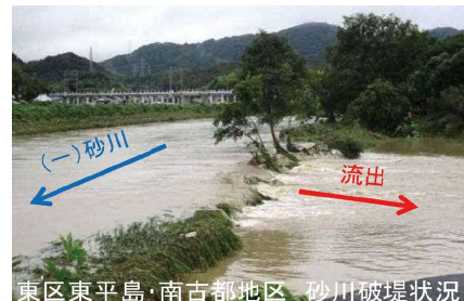
図-7 平成30年7月豪雨時 岡山市内の被害状況
