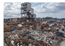
輪島市の火災被害
