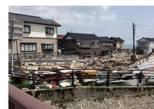
珠洲市 鵜飼漁港の津波被害
