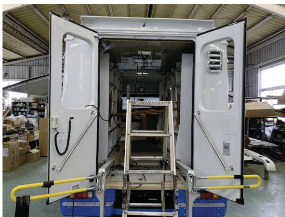
艀装工程③ （車椅子用リフトの組み付けが完了）
