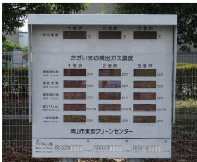
図 6-3 東部クリーンセンターに設置している排ガス濃度監視盤
