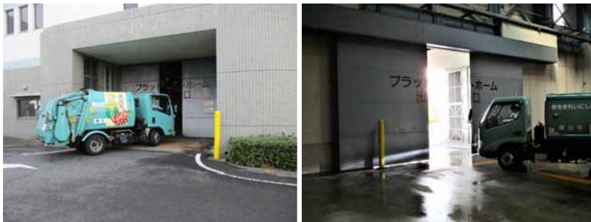
図 6-4 自動扉やエアカーテンの設置例
