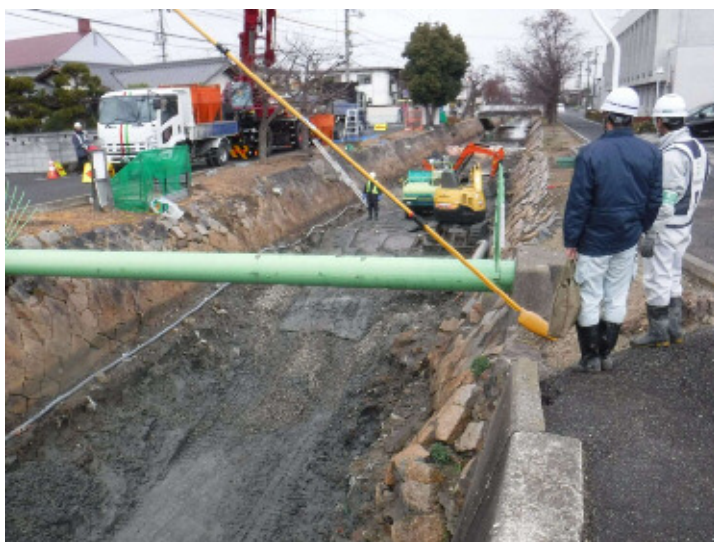
浦安雨水幹線整備事業の様子。既存の排水路を掘削しコンクリートで改修することにより、雨水の流れをよくしています。
