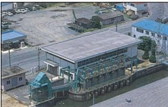
写真2-2-1 岡南ポンプ場（現状）
