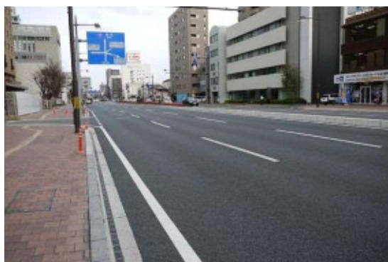
写真2-6-3 排水性舗装施工状況
