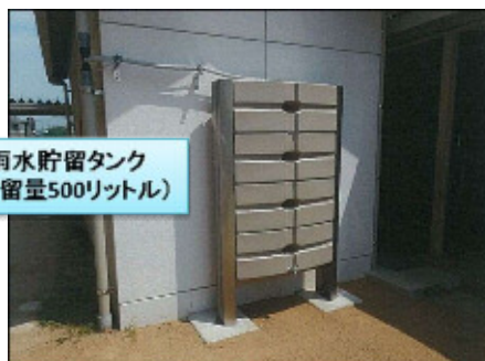
写真2-6-1 雨水貯留タンク設置状況（南輝小学校）
