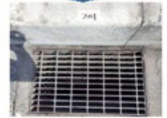
道路施設の排水機能確保
