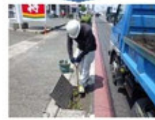
側溝や集水桝の点検を強化し、不具合箇所の清掃などを実施
