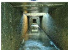
側溝や集水桝の土砂堆積
