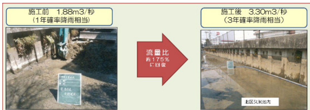
図2-4-6 幹線水路の浚渫の事例
