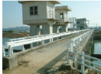
砂川堰管理橋
