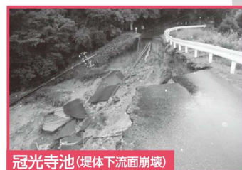
冠光寺池(堤体下流面崩壊)
