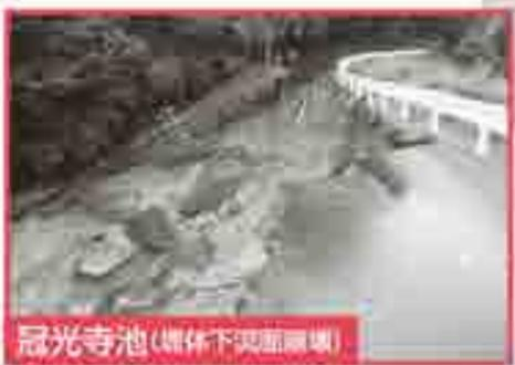
冠光寺池(堤体下突面破壊)
