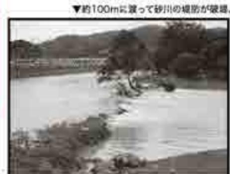
約100mに渡って砂川の堤防が破壊。
