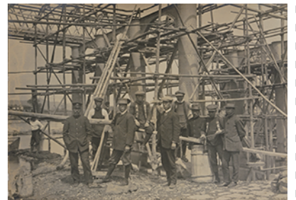
建設中の京橋と、技師・人夫たち(小西隆技手の写真帖から)
