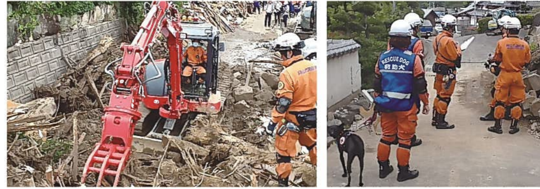
▲重機による土砂の除去作業
