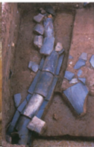
暗渠排水施設
