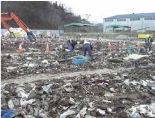
災害廃棄物を展開し手選別及び重機による危険物類・貴重品等を一次選別 (岩手県宮古地区)
