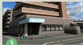
3 壱番館南側駐車場 (3台)
