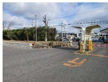
⑪第3駐車場 出口付近 (左折出庫誘導)
