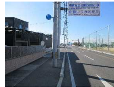
⑦-3 空港線 ソフトボール場 東側(右折誘導)
