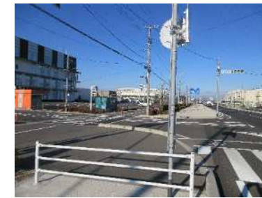
⑥-1 南区役所 北東出入口 ゲート北側(西進誘導)
