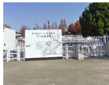
②④-8 プール(入口付近)
