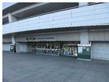
②④-2 JFE 晴れの国スタジアム (入口付近)
