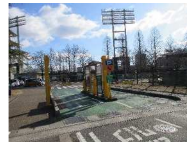
③-1 第1駐車場(入口付近)
