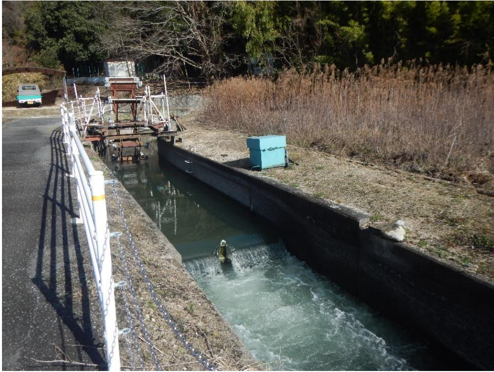
転倒堰下流側から
