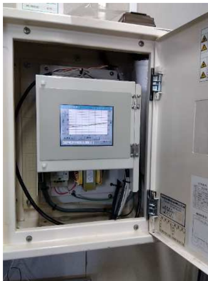
■空冷チラーグループコントローラー現場写真（中央図書館 1 階管理室内）
