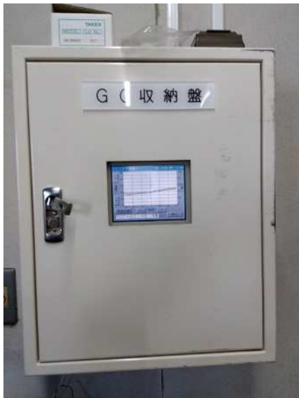
■空冷チラーグループコントローラー現場写真（中央図書館 1 階管理室内）
