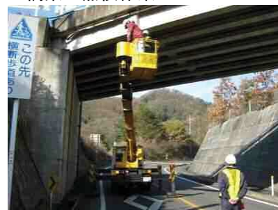
■ 橋梁の点検作業
