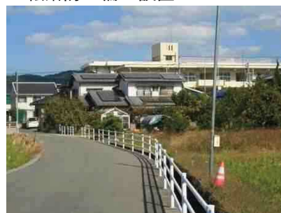
■ 転落防止柵の設置
