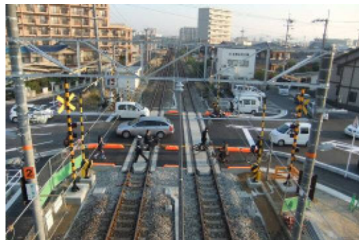
■改良された第二西市踏切
