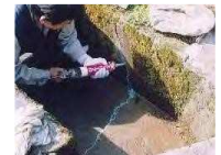
水路のひび割れ補修
