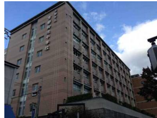
京都市初の大規模な複合施設となった京都御池中学校を含む高層の複合施設
