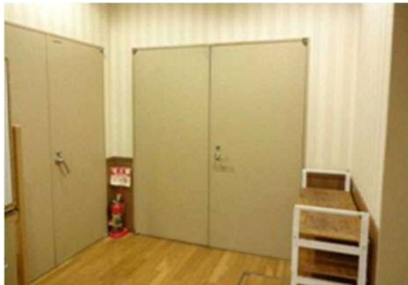
施設内の連絡扉
