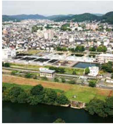
市内に水道水を供給する三野浄水場
