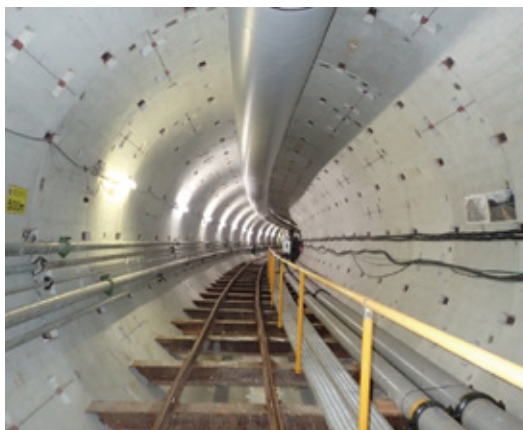
浦安11号幹線シールド工事
