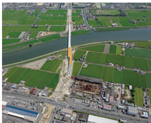
工事が進む市道藤田浦安南町線
