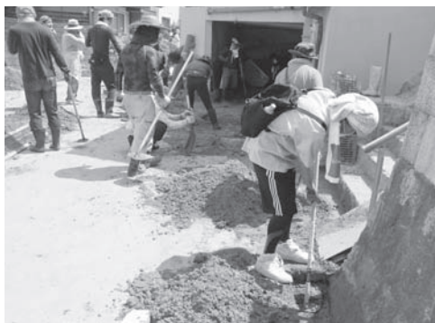
土砂の撤去作業を行う災害ボランティア
