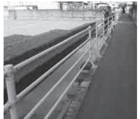
転落防止柵を設置した用水路
