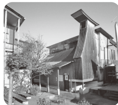
改修予定の温泉会館
