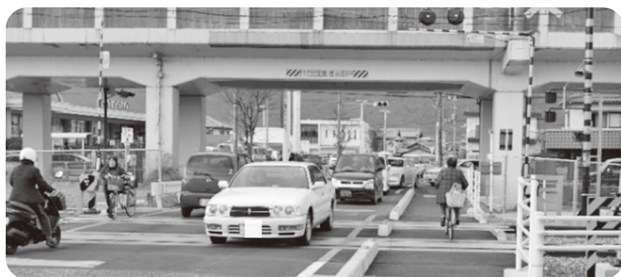
整備後の山陽本線前沼一踏切 ～中区雄町地内～
