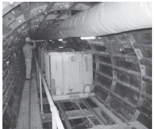
豪雨対策のため工事が進む瀬戸雨水幹線
