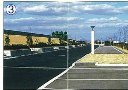
カラー舗装の駐車場と監視棟
