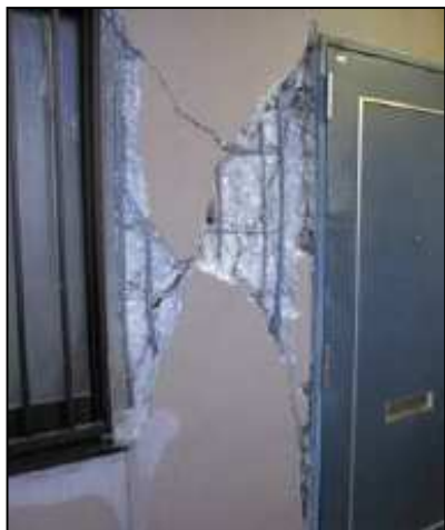
③ コンクリート壁等が破損
