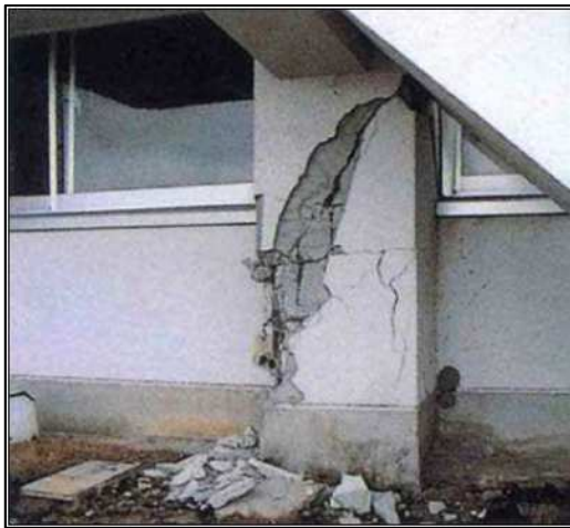
③ 建物の基礎が破損
