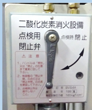
閉止弁の設置
