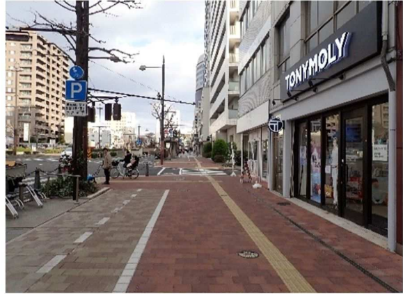
視覚障害者誘導用ブロックの設置
