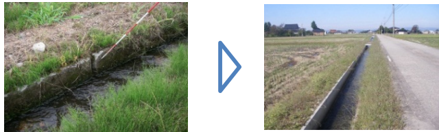
老朽化した水路の整備
