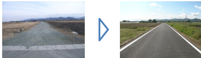
農作業道の整備
