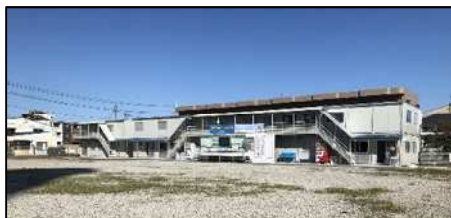
仮設事務所設置
