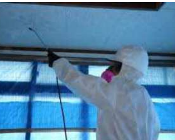
噴霧器 (除去作業中の湿潤)
