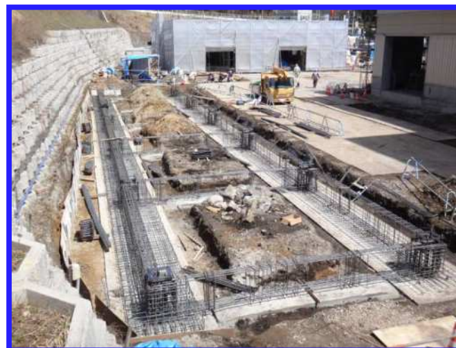
コンクリート工事
