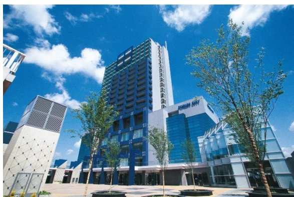
岡山コンベンションセンター
