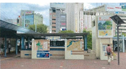
現在の地下街との連絡階段
