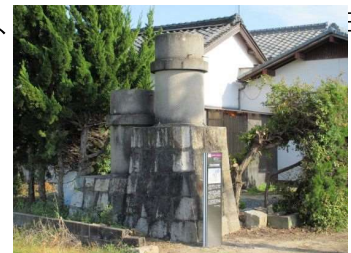
横樋の共同濾過槽
