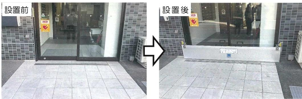
写真2-9-4 止水板の設置状況
